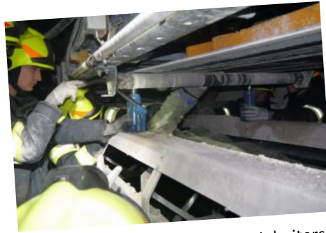
Befreiung des eingeklemmten Arbeiters mittels zweier Hydraulikheber
